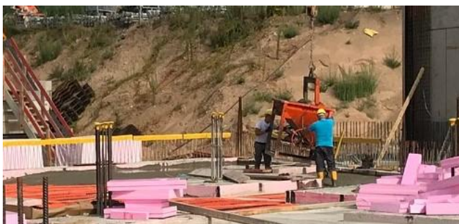
In drei Bauabschnitten wurde der Erdspeicher auf zwei Ebenen verlegt.
