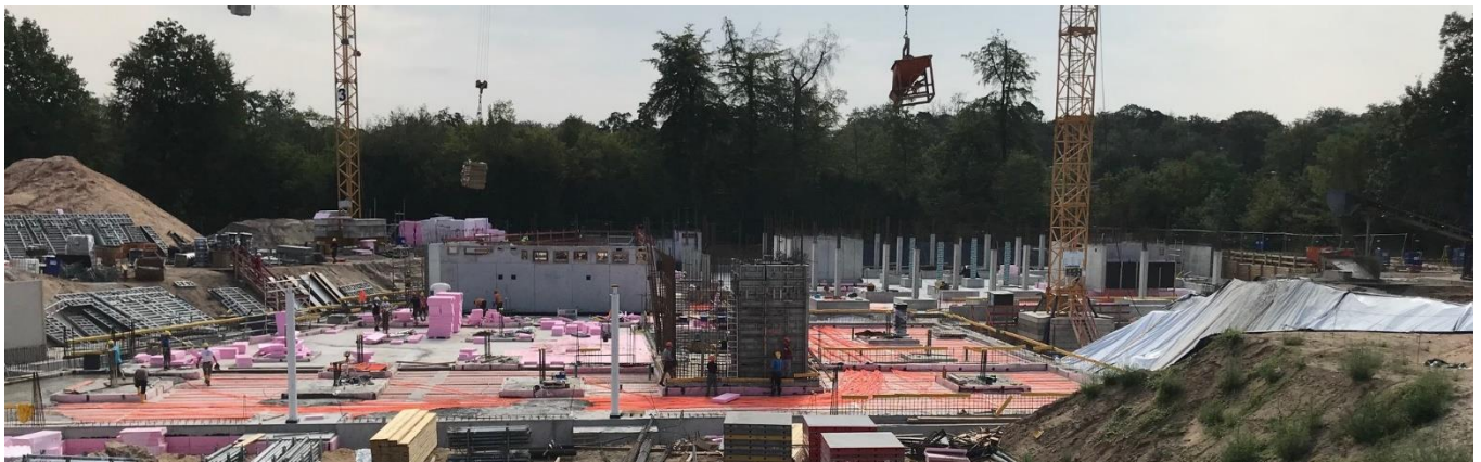
Der 4.600 m 2 große Erdspeicher steht vor der Fertigstellung.
