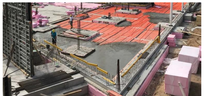
In drei Bauabschnitten wurde der Erdspeicher auf zwei Ebenen verlegt.
